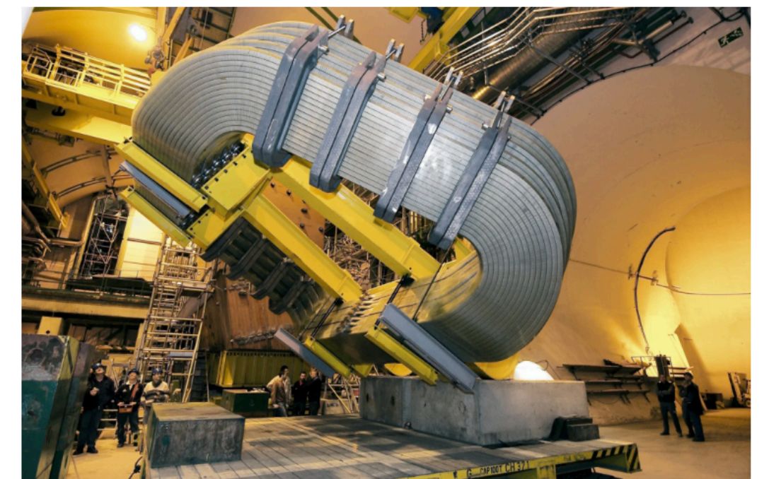
Magneet voor de LHCb-detector in CERN bij Genève, ten tijde van de installatie. Foto ANP
